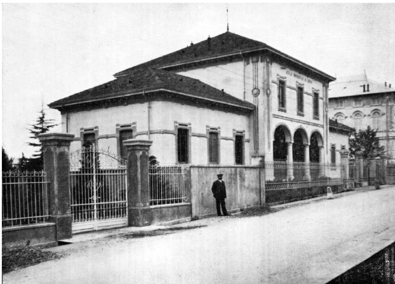
Figura 1 Immagine storica del primo corpo di fabbrica
