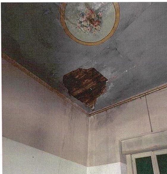
Viene quindi previsto la totale rimozione della controsoffittatura in arelle onde a far risultare visibili i travetti e l'assito per eseguire una puntuale verifica del loro stato di conservazione.
